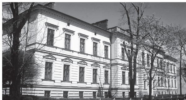
Ryc. 6. Klinika Chirurgiczna, ul. Kopernika 40, elewacja frontowa, 2006 r. (fot. aut.)
