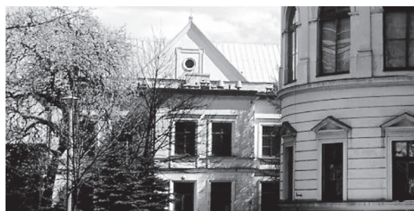
Ryc. 7. Klinika Chirurgiczna, ul. Kopernika 40, elewacja tylna, sala wykładowa, 2006 r. (fot. aut.)
